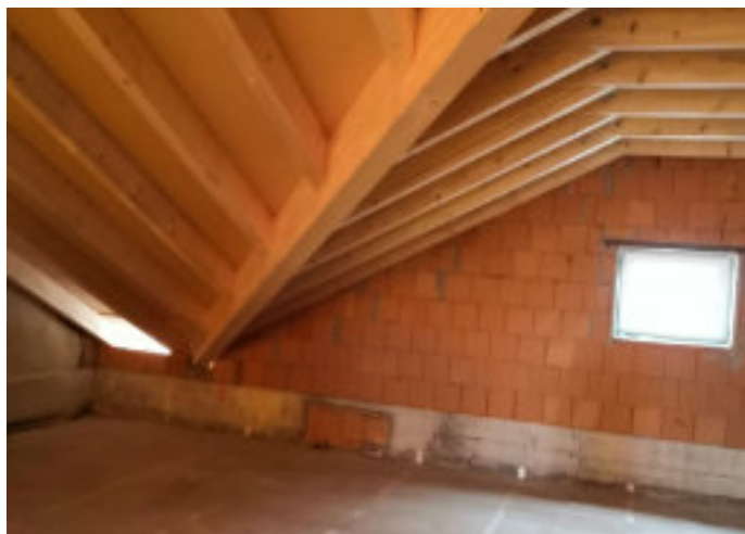
Dachstuhl Mehrzweckhalle Aufkirchen
