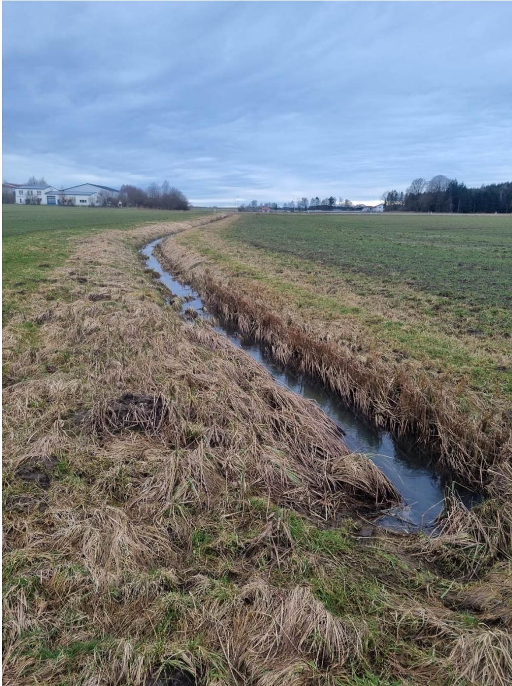
Abbildung 8: Nördlich angrenzender Bachverlauf. Blick nach Nordosten.
