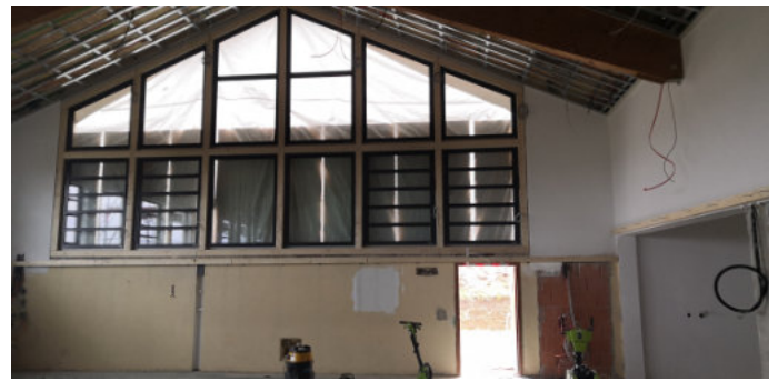
Mehrzweckhalle Aufkirchen - Ausbauarbeiten schreiten voran
