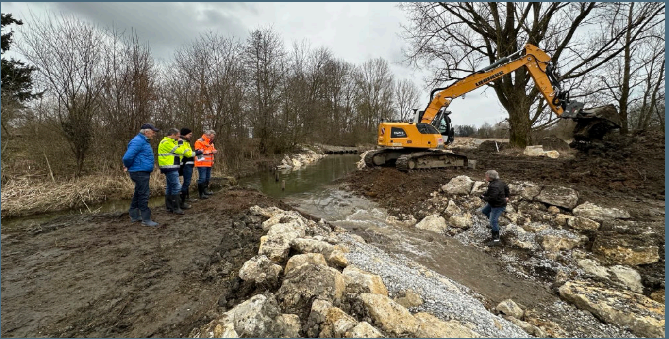
Glondurchstich im März 2025 (Bild: LRA FFB)
