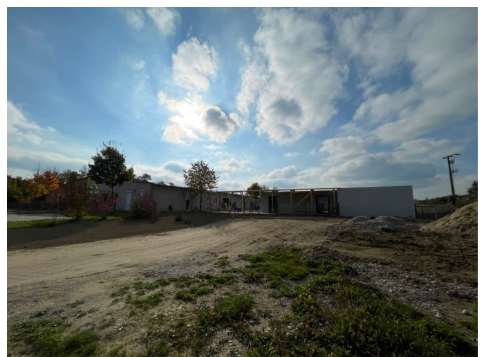
Container-Anlage Kindergarten Egenhofen
