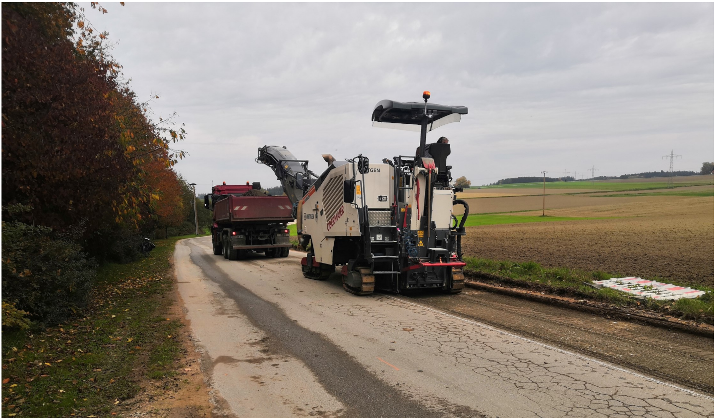
Sanierungsarbeiten Ortsverbindungsstraße Oberweikertshofen-Eurastetten
