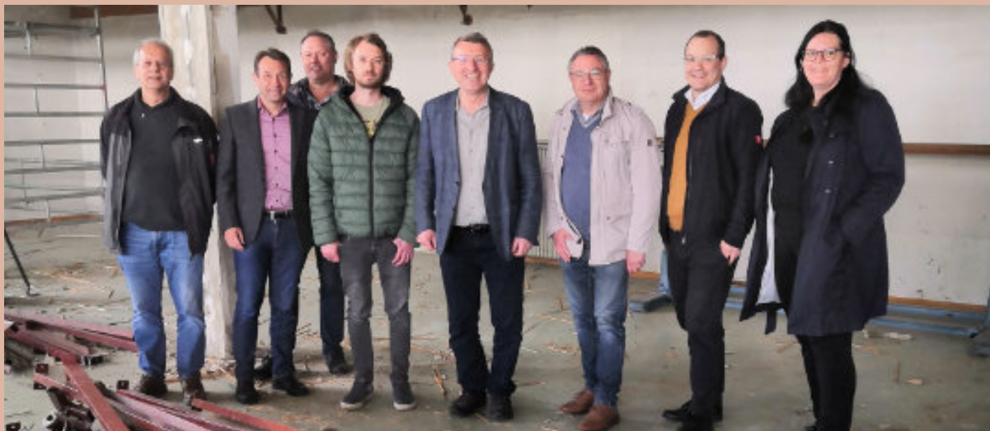
Eine Woche nach dem Start der Baumaßnahme an der Schulturnhalle und Mehrzweckhalle Aufkirchen fand vor Ort eine Baustellenbesprechung statt.
